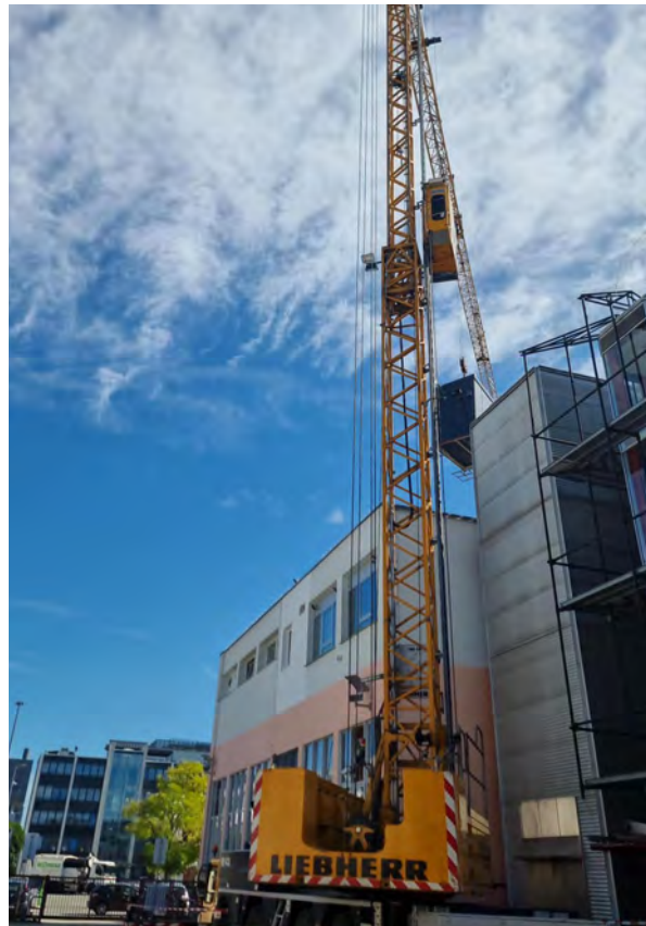
Schweres Gerät war nötig, um das Versuchshäuschen samt Stahlträger vom Dach des FIW München zu bekommen.
